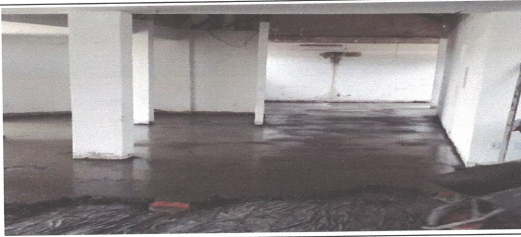
INSTALAÇÃO DE FORRO DE GESSO
