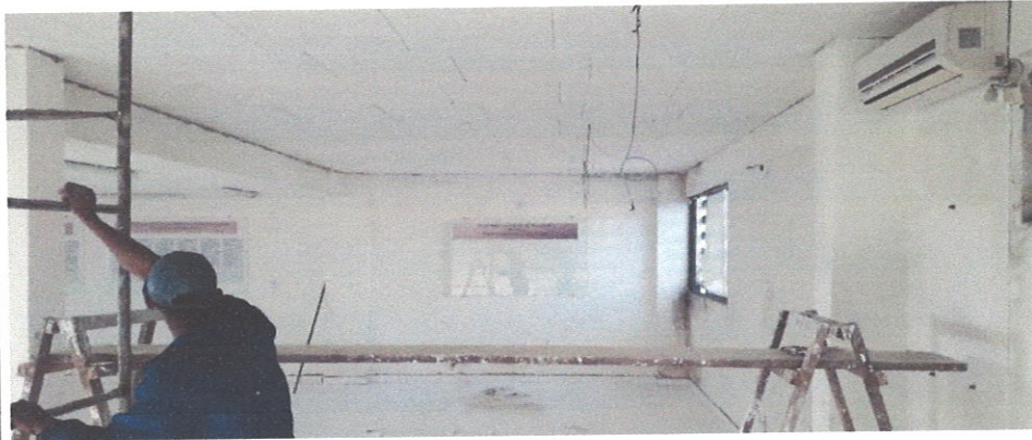
INSTALAÇÃO DE FORRO DE GESSO
